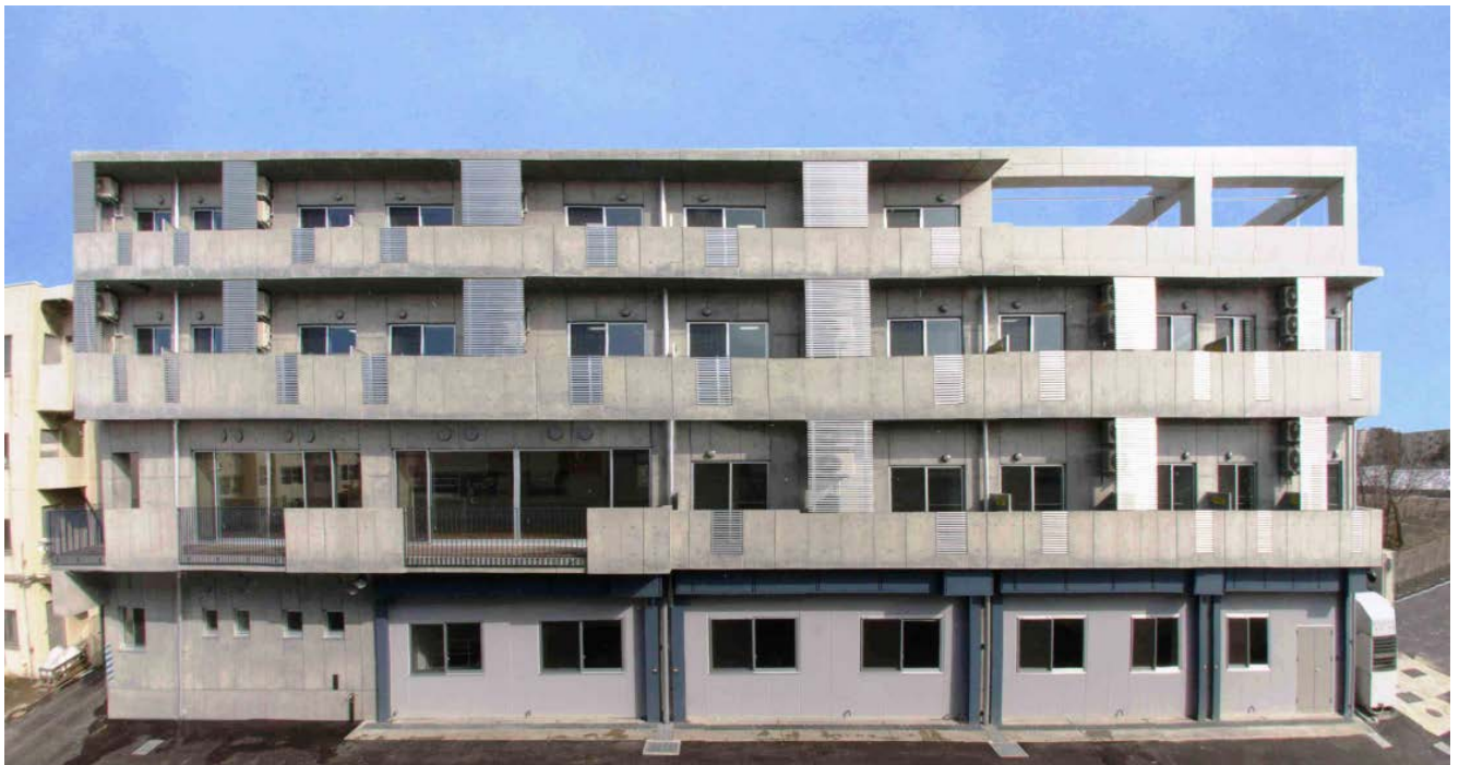
新潟県警察機動隊宿舎棟
